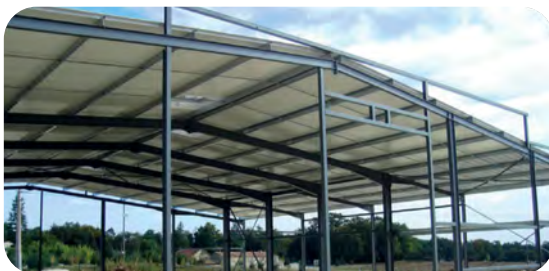
Tiefenmarkierung auf Metallträgern
