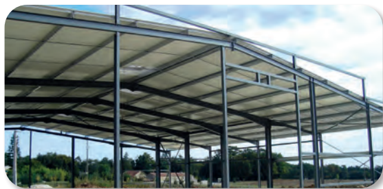
■ Marquage profond sur charpentes métalliques
